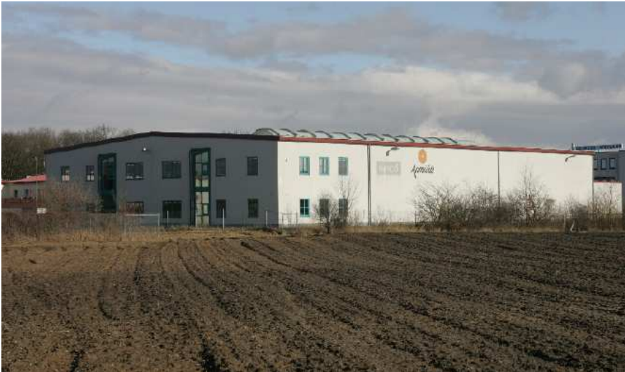
Die Schaltzentrale von Kümme-Textil in Kitzingen. Von hier aus gehen die Lieferungen für Arbeitshemden und Blusen in die ganze Welt
