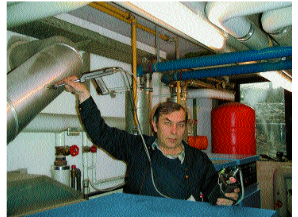
Kaminkehrermeister Peter Felix bei der Abgasmessung
