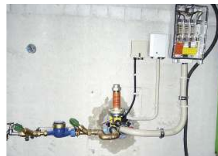
Robert Vetter, Gasrohrnetz-Monteur, zeigt, wie's geht: Eine Kernbohrung im Haus reicht, um Strom, Erdgas, Wasser und Telekommunikation zu verlegen. Auch eine Durchführung der Leitungen durch den Fußboden ist möglich
