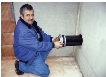
Robert Vetter, Gasrohrnetz-Monteur, zeigt, wie's geht: Eine Kernbohrung im Haus reicht, um Strom, Erdgas, Wasser und Telekommunikation zu verlegen. Auch eine Durchführung der Leitungen durch den Fußboden ist möglich
