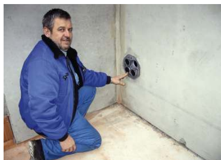
Robert Vetter, Gasrohrnetz-Monteur, zeigt, wie's geht: Eine Kernbohrung im Haus reicht, um Strom, Erdgas, Wasser und Telekommunikation zu verlegen. Auch eine Durchführung der Leitungen durch den Fußboden ist möglich
